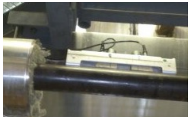
Abb. 4 Demontage der Dämmung und Montage der Messleiste. (Quelle: Planair SA)
